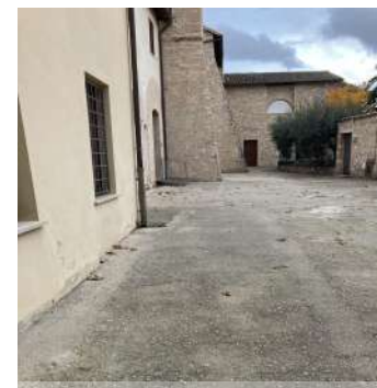
8.2C_Pavimentazi one disconnessa
