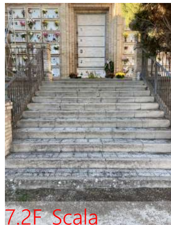
7.E_Pavimentazione disconnessa
