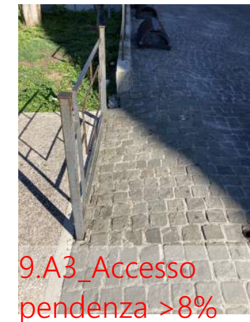
9.A3_Accesso con pendenza superiore 8%
