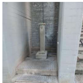
7.Z_Gradini per raggiungere acqua
